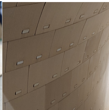
13. 部材を組み上げた小屋の壁面
